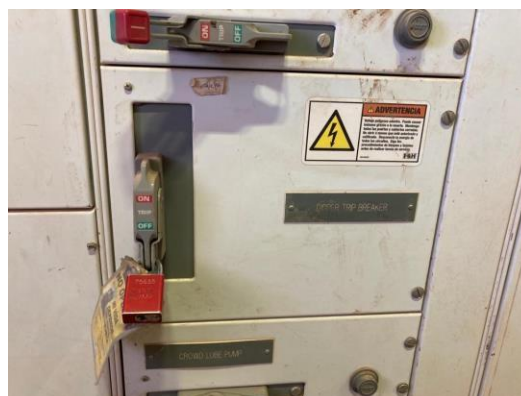
Bloqueo en breaker de alimentación motor abrir balde
