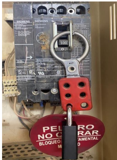
Bloqueo en breaker de alimentación motor abrir balde
