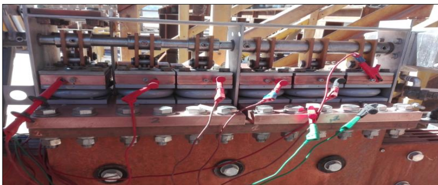
Imagen 2.1 Muestra instalación de cables en Switch.
