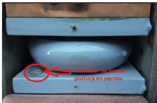
Imagen 2.1 Muestra que pernos quedan bien instalados.
