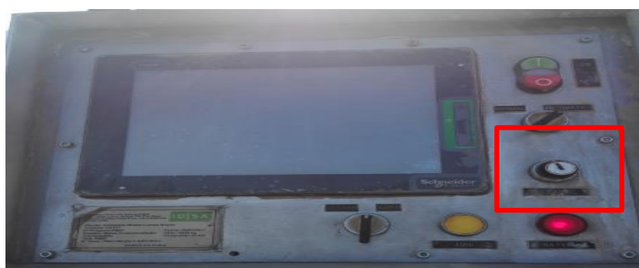
Imagen 2.1 muestra punto de instalación de llave en panel principal
