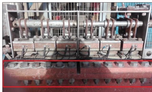
Imagen 3.1 muestra retiro de pernos de sujeción de Switch 1 y 2.
