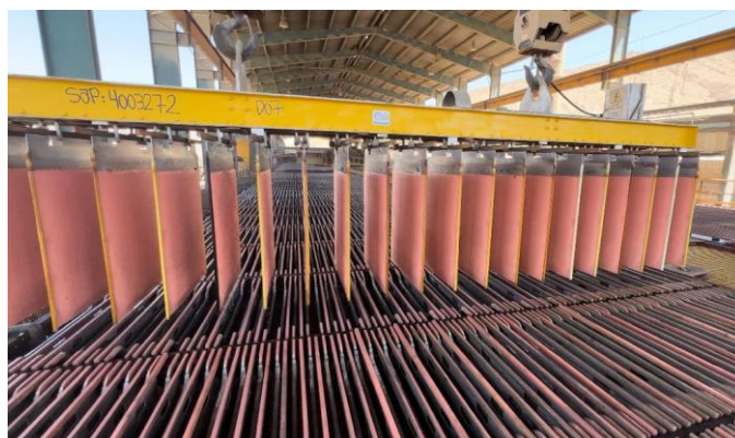
Foto 2: Operador retirando lingada desde correa de salida de la máquina despegadora.
