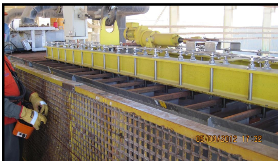
Foto 4: Operador ingresando lingada desde celda a correa de la maquina despegadora
