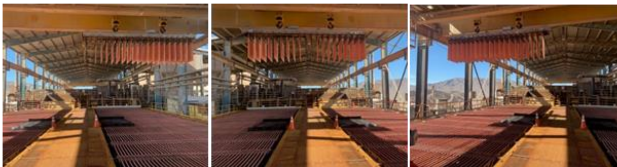
Figura 5: Secuencia de Transición en lado “A” para trasladar lingada a cadena de carga MDC.
