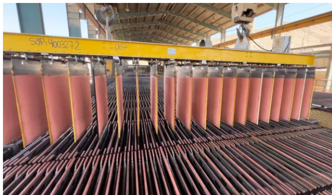
Figura 2: Operador retirando lingada de celda con alza cátodos para conducirla a la maquina despegadora.
