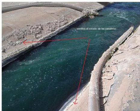
Imagen N°5: Verificación del estado de las carpetas de las canaletas para evitar filtraciones y daños al ecosistema.
