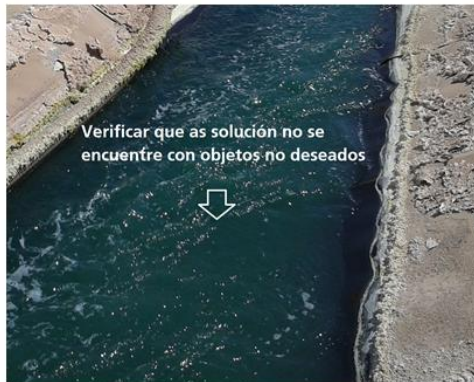
Imagen N°3: La solución que corre por las canaletas deben estar libres de sólidos u objetos extraños, ya que estos pueden afectar el proceso en la planta de SX-EW.
