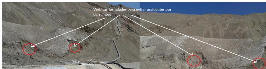
Imagen N°4: Verificación de taludes en derrumbe para evitar accidentes y que material sólido entre en el cauce de la solución PLS.
