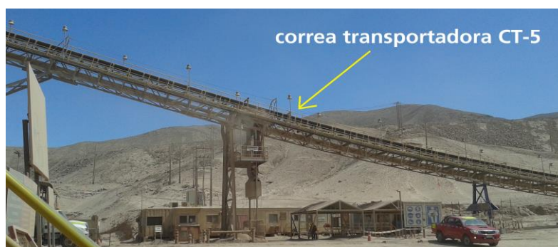
Imagen N°7: Indicación del lugar de correa transportadora CT-5
