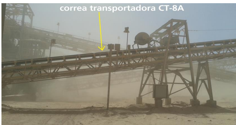
Imagen N°10: Indicación del lugar de correa transportadora CT-8A
