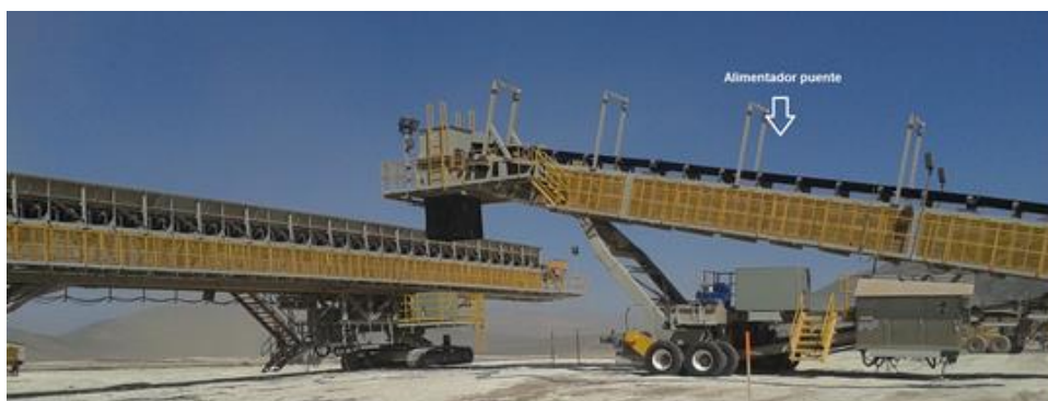
Imagen N°1: Alimentador puente lado derecho de la imagen como se indica.
