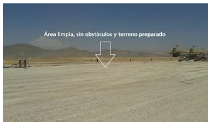
Imagen N°5: Preparación de terreno para Mov. De portables
