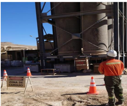
Figura N°4: Operador fuera del radio de movimiento del polipasto
