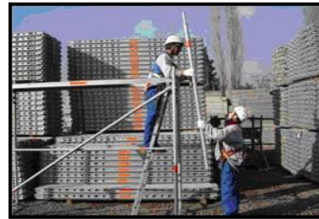
Figura 27. Dos personas para montaje y desmontaje de andamio.
