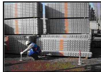
Figura 28. Preparación de base para montaje de andamio.
