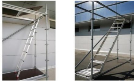
Figura 26. Andamio con escalera y escalera interna.
